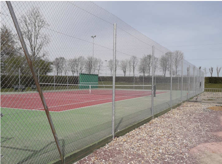
Remplacement d'une partie de la clôture du court de tennis, endommagée lors de la tempête « Aurore » en octobre dernier. Travaux pris en charge en partie par l'assurance.
